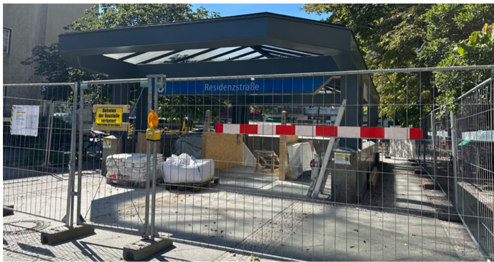
Auf dem Weg zur Barrierefreiheit – Baustelle am U-Bhf Residenzstraße
